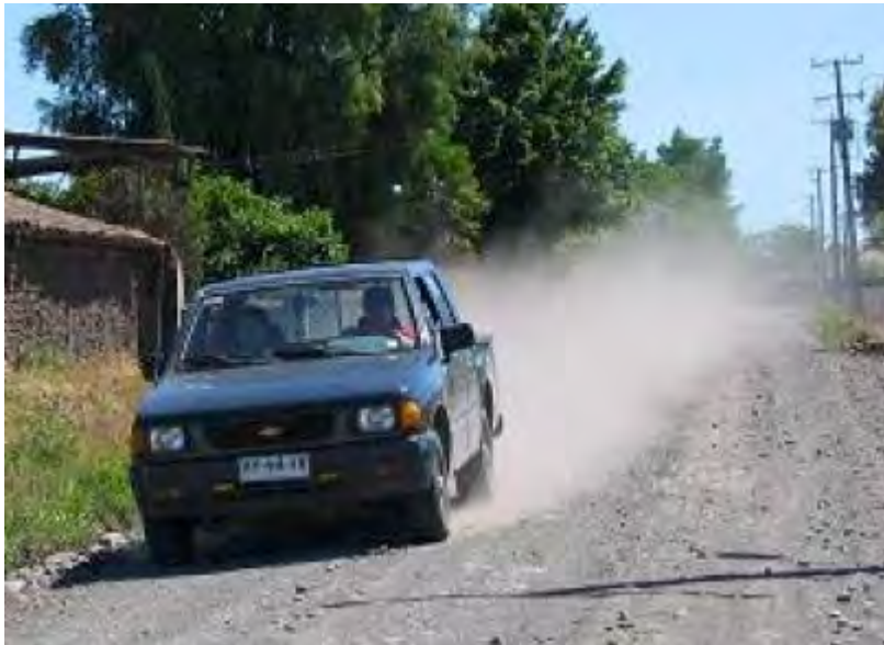
Figura 3-n: Vehículo Circulando por camino sin tratamiento - Bellolio, 2005.
